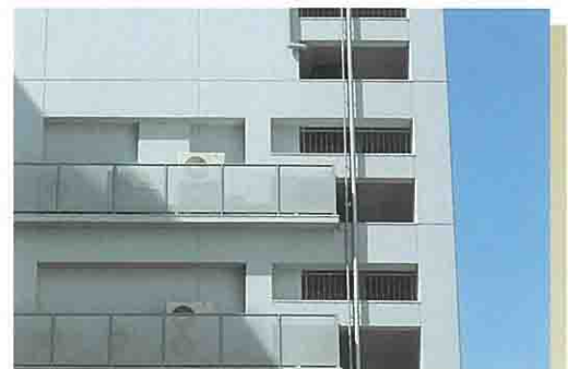
排水管を一本にまとめるとともに、外壁に付帯する設備は道路等から見えにくいよう、工夫しています。
