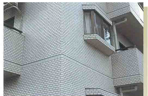
窓、ベランダを同じ仕上げとするとともに、同色でひかえた排水管としています。
