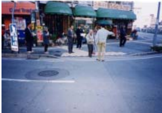
写真 設置方法等の問題がある誘導用ブロック
