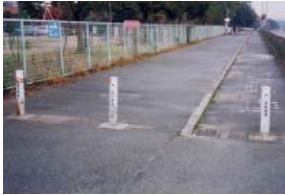
写真 表示が消えている歩行者自転車道
