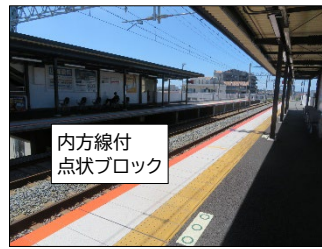
〔内方線付き点状ブロックの設置〕 山陽電鉄 別府駅
