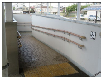
〔スロープ設置〕 JR加古川線 神野駅
