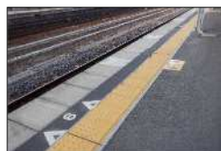
JR西日本東海道本線 安土駅
