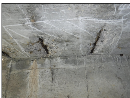
主桁に剥離・鉄筋露出が見られます
