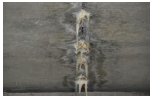
つらら状の遊離石灰の発生
