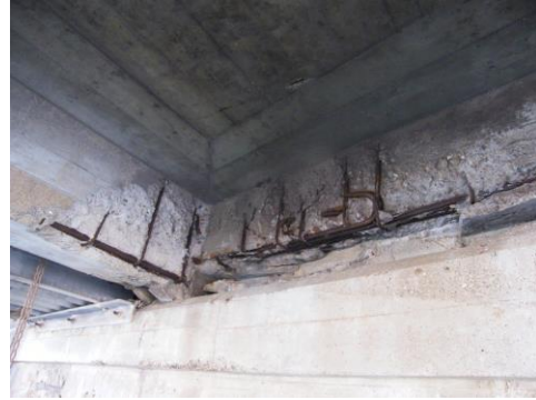
コンクリートの剥離及び鉄筋の露出
