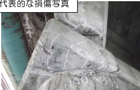
橋脚梁部の剥離及び亀裂の発生
