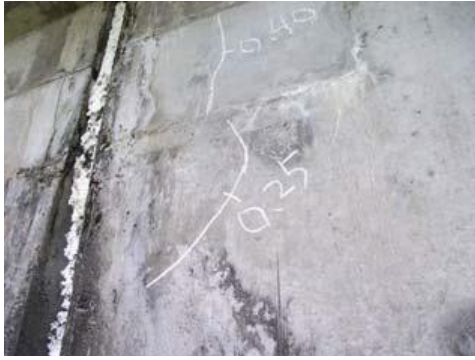
PC定着部のひび割れの発生
