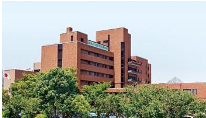
現加古川西市民病院
