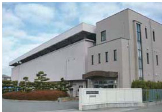
安田中継ポンプ場
