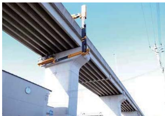
点検車を用いた橋梁点検
