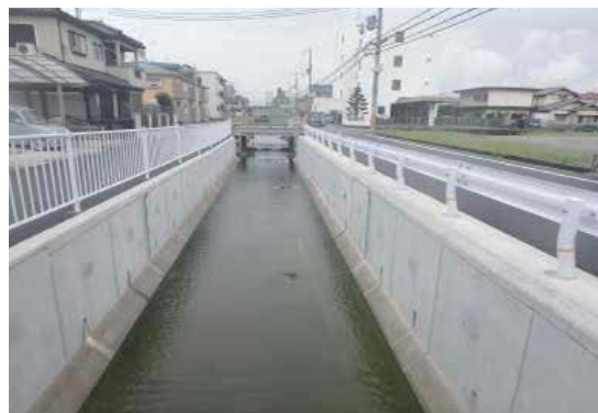
下水道（雨水幹線）の整備
