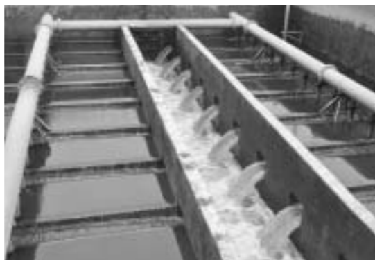
2～3日に一度、ろ過池の砂を下から水道水で逆噴射して洗浄します。迫力満点です！
