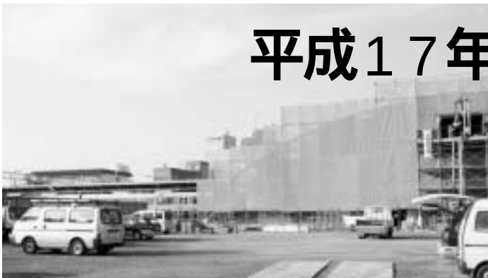
▲整備が進む JR 東加古川駅北口。
