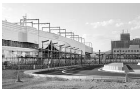
整備が進む加古川駅北広場。
