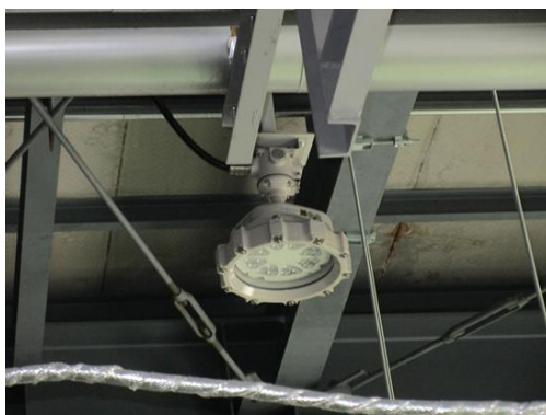
ア.防爆型水銀灯の LED 化
