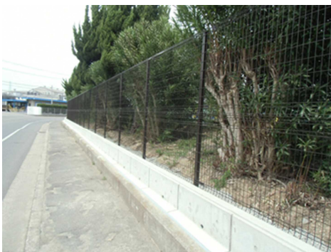
フェンス整備に伴う緑地整備
