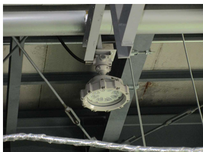
ア. 防爆型水銀灯のLED化
