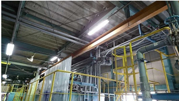
工場建屋 照明LED化(写真①)
