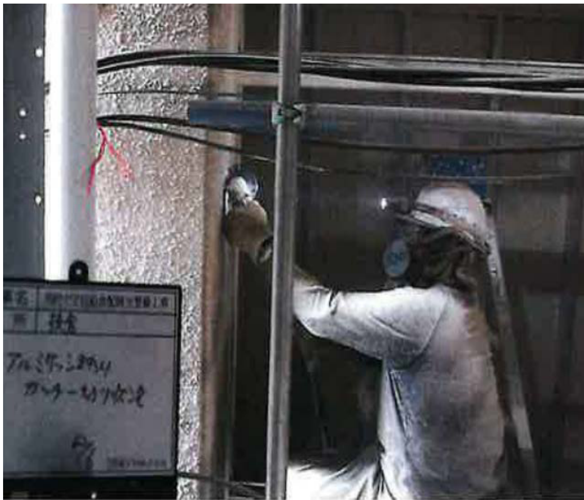
窓枠内外両側カッター切り作業
