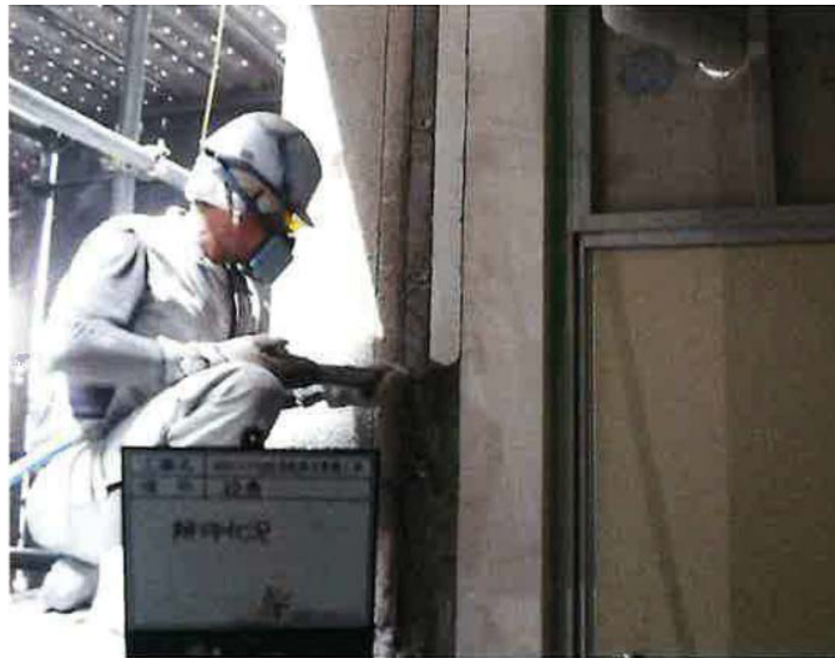
ハンドブレイカーで窓枠破り
