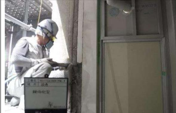
写真 1.3 窓枠の研り作業 2020/8/8
