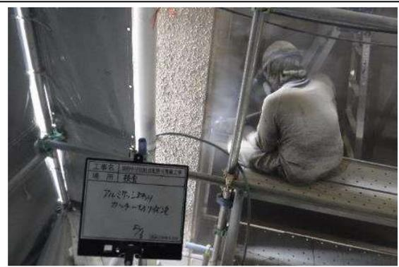
写真 1.2 窓枠のカッター切り作業 2020/8/6
