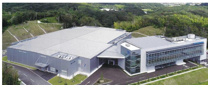
最新鋭の淡路第9工場
