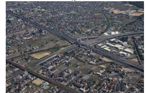
《ものづくりを支える道路網(加古川中央ジャンクション)》
