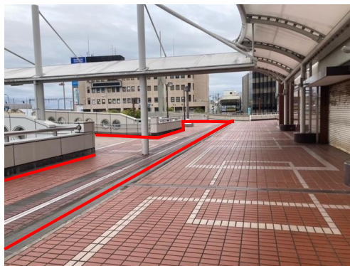
▲普段のデッキ②の様子
