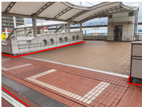
▲普段のデッキ①の様子
