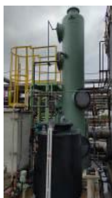
発酵分解槽 脱臭塔更新
