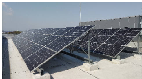
事務厚生棟屋上に太陽光パネル設置
