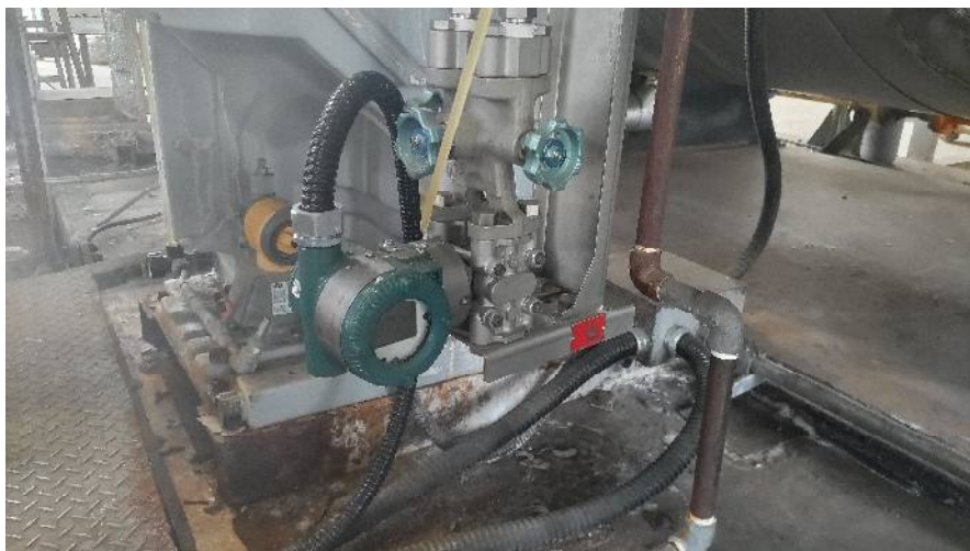
F Tボイラー ブローライン流量計設置
