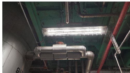
照明LED化工事
