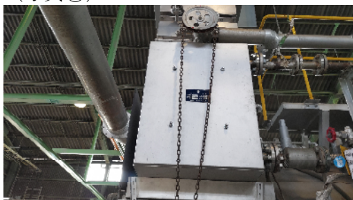
FTボイラーのエコマイザー更新
