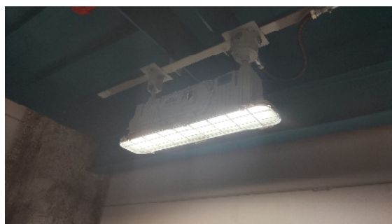
照明LED化工事
