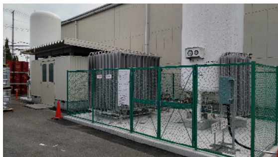
窒素自製装置 (PSA) 大型化更新
