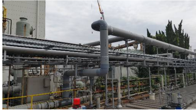
スクラバーバックアップ配管増設
