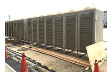
仮設トイレが設置されます
