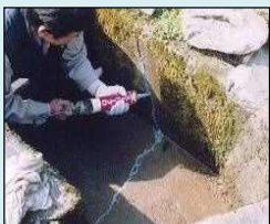
ひび割れの補修
