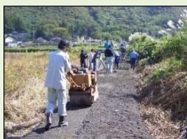
未舗装農道の舗装
