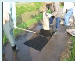
農道の部分補修
