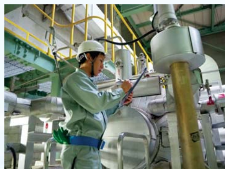
ボイラー汽水調の圧力を確認 【クリーンセンター】
