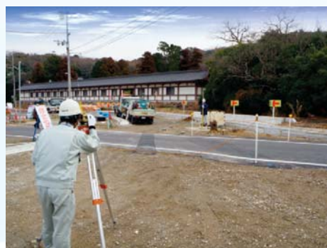
市道大野西条線道路改良工事の出来高検査 【道路建設課】
