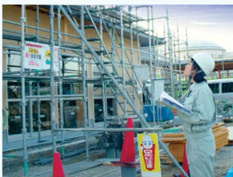
川西こども園建設工事の現場監理 【営繕・住宅課】
