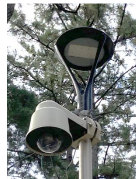
【ポールB】 ラムス#1設置 ポール先端までの高さ:4.5m ※見守りカメラ共架
