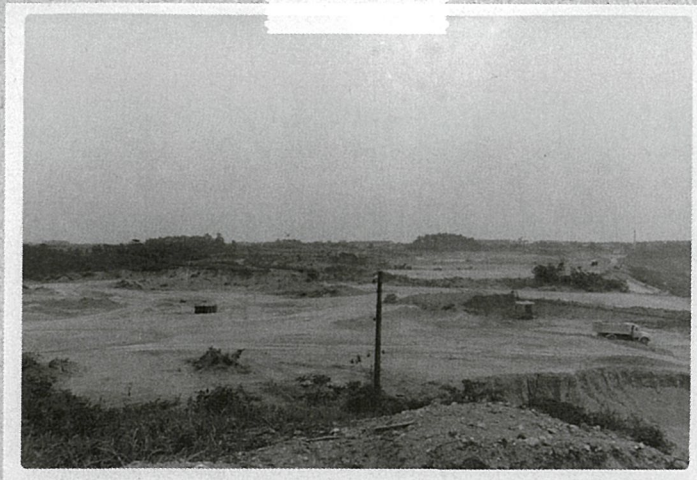
造成工事の様子
