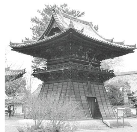
鶴林寺鐘楼（重要文化財）
