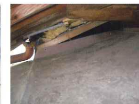
屋根裏につながる隙間
