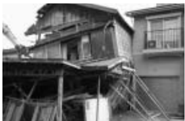
新潟県柏崎市の家屋倒壊の様子
