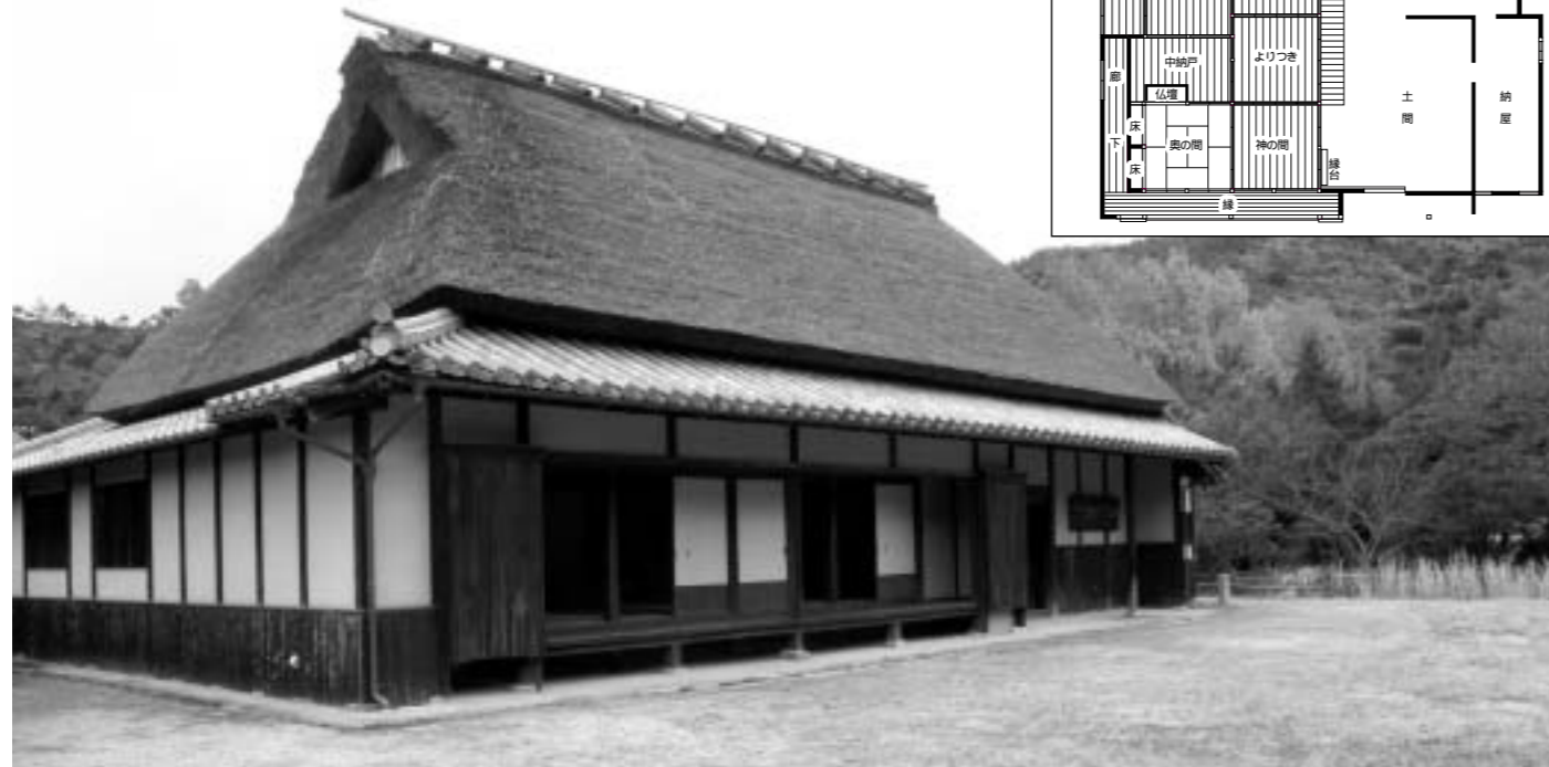
移築復元された本岡家住宅の表側
