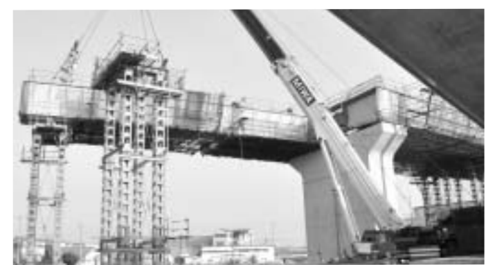
寒空の中、橋桁の上では10人の作業員が手際よく作業。安全第一ですね！
