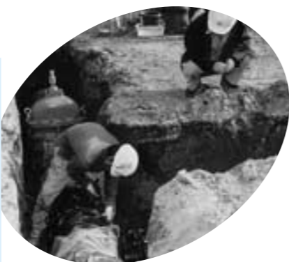
水道配水管工事の現場
