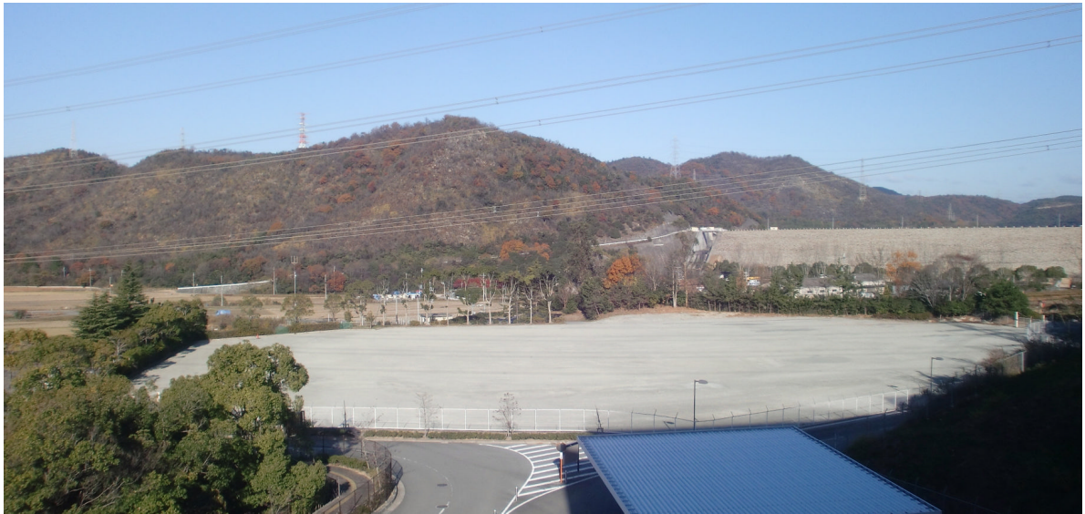
解体撤去完了 全景写真
