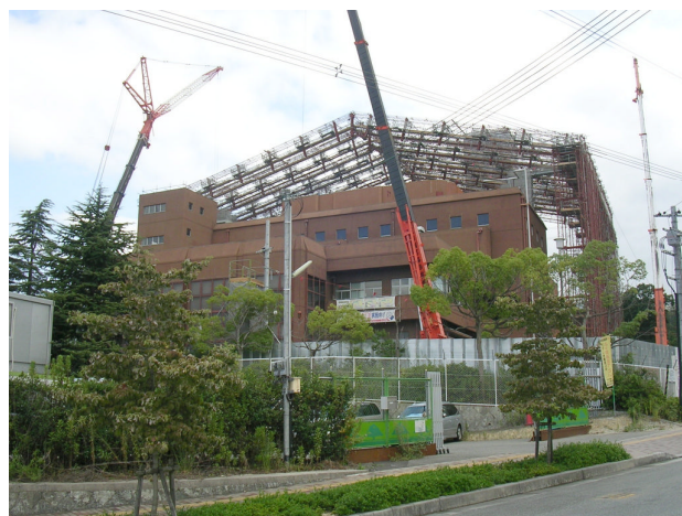
施設南面 焼却棟密閉養生鉄骨組立 （8月31日撮影）
