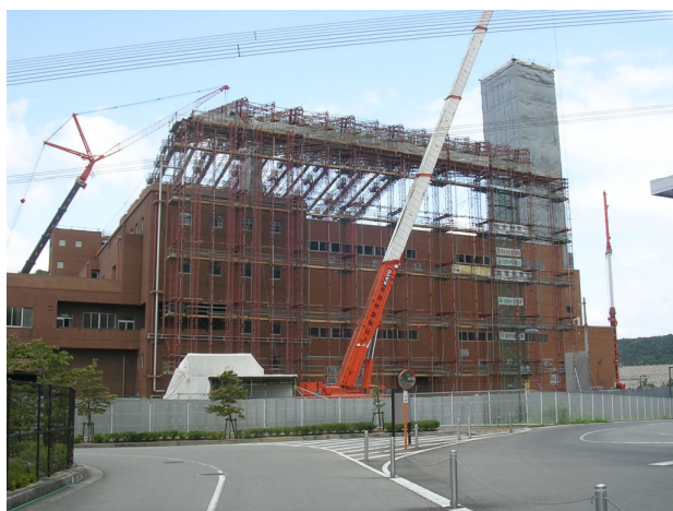
施設東面 焼却棟密閉養生鉄骨組立 煙突解体工事中（8月31日撮影）
