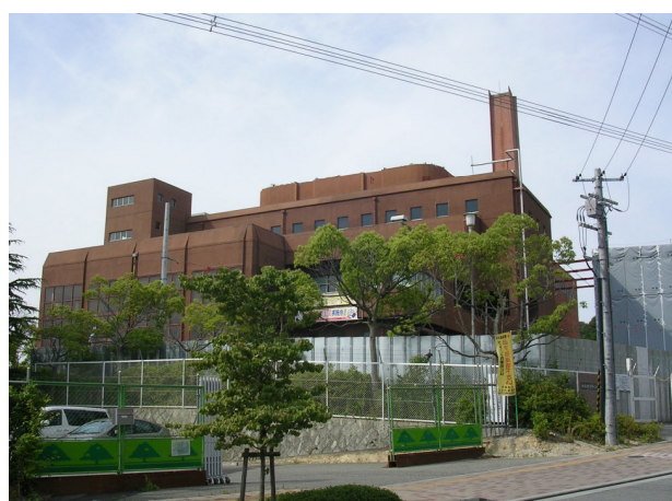
施設南面 屋上復水器撤去済
