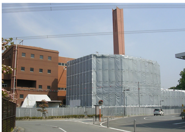
施設東面 冷水塔密閉養生
