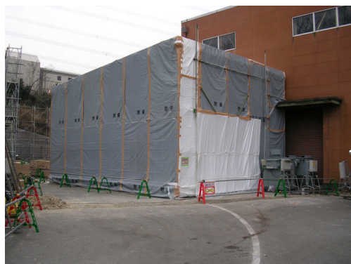
土壌汚染部密閉養生 1月29日
