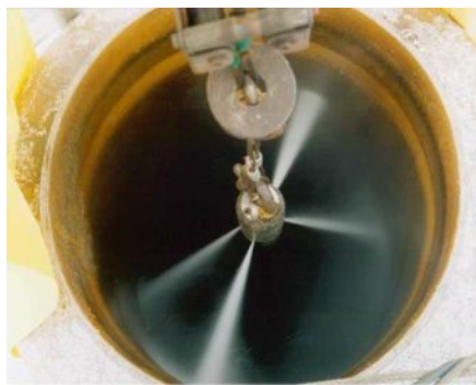
遠隔操作による煙突洗浄(例)
