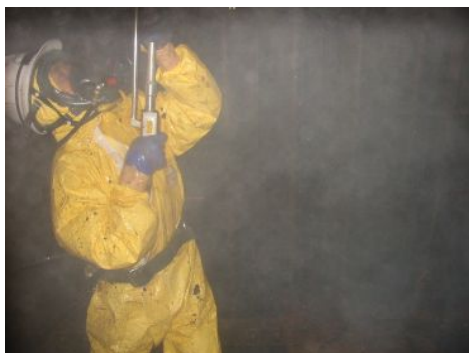
直接洗浄状況(例)
