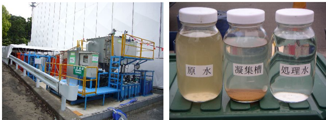
水処理装置及び下部防液提(例)
