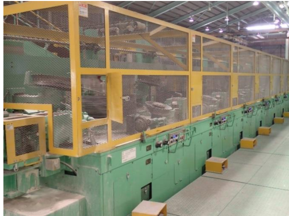
図2 伸線機の新設
