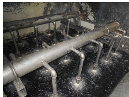
散気管テスト状況(写真④)
