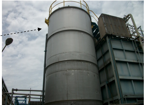
工程排水の処理量を平準化
