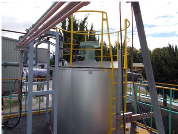
図3 水処理設備 逆中和タンク更新
